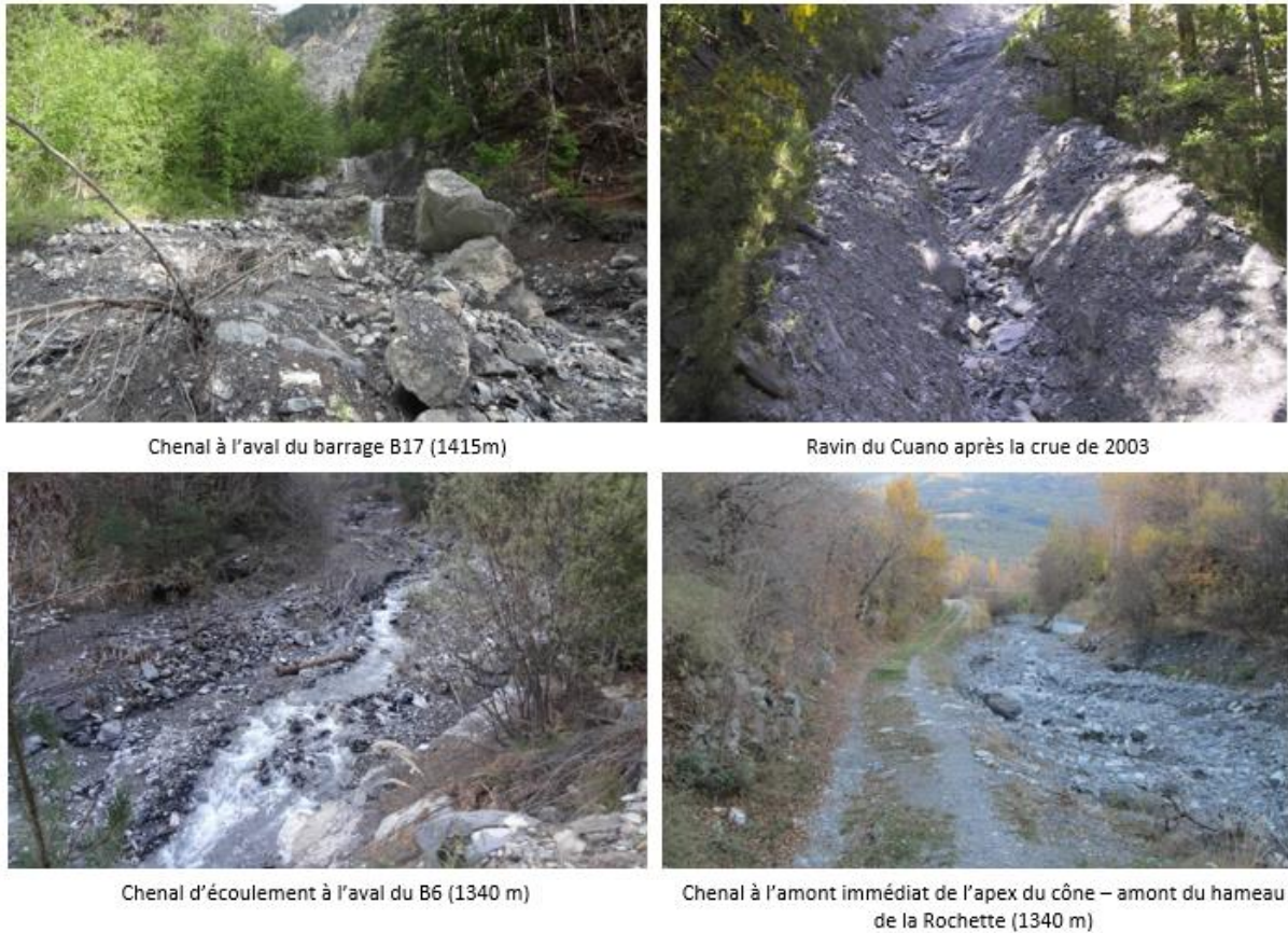
Figure 28. Aperçus du chenal d'écoulement à l'aval de la zone d'éboulement
