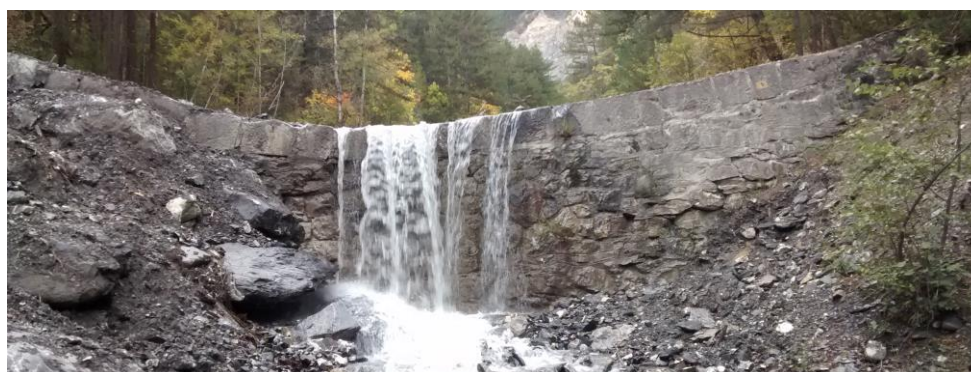
Figure 68. Photographie de l'ouvrage B9
