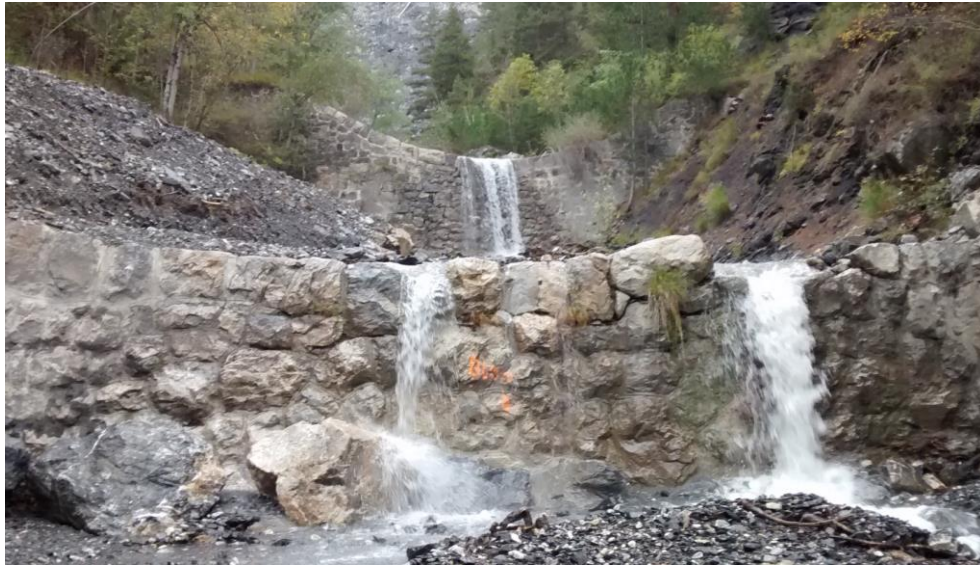
Figure 69. Photographie des ouvrages B17 et B18
