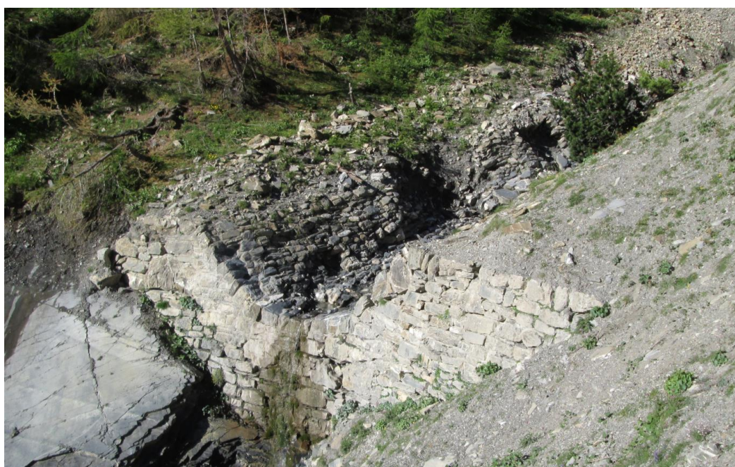
Figure 55. Clapière Jausiers– Photographies du barrage B1 et se son pavage amont
