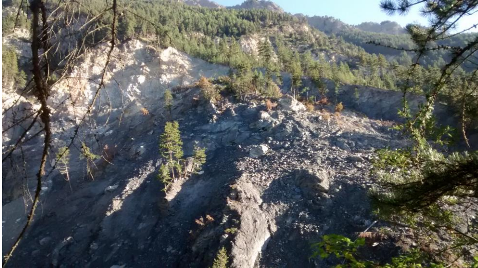
Figure 41. Photos de a partie supérieure de l'éboulement (09/09/2014)
