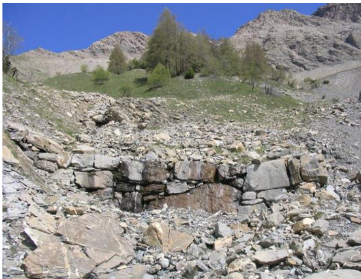
Figure 74. Photographie d'un seuil en pierres sèches – Clapière Faucon
