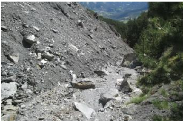
Partie intermédiaire de l'éboulement : comblement du lit
