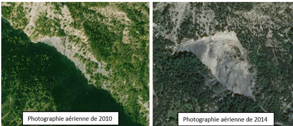
Figure 46. Comparaison des photographies aériennes de 2010 et 2014 dans le secteur de l'éboulement
