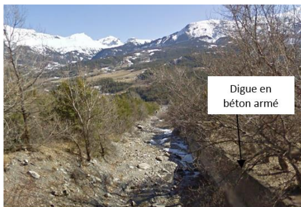
Digues vues depuis le pont de Briançon (vue vers l'aval)
