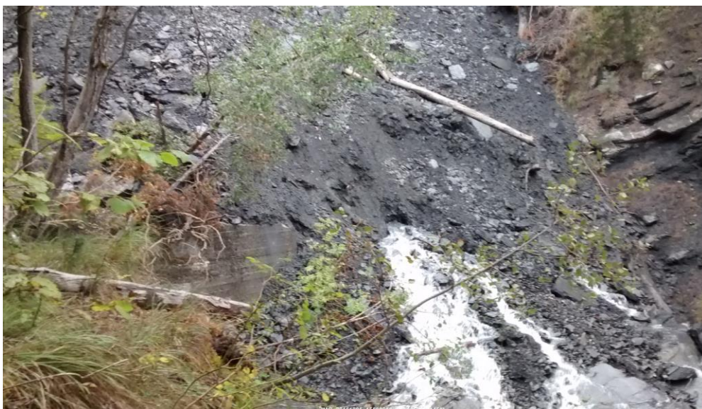
Figure 70. Photographie de l'ouvrage B19 (seule l'aile rive droite est apparente)
