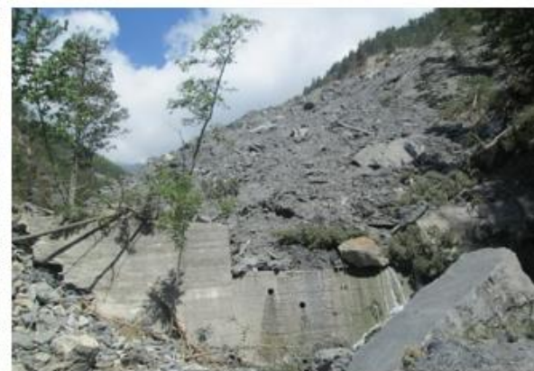
Extrême partie aval de l'éboulement, barrage B19 (1448 m)
