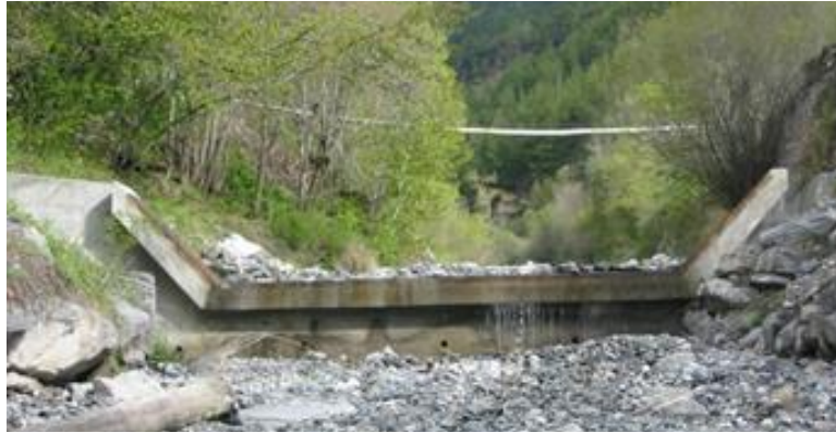
Figure 57. Photographie du seuil communal au droit du CCAS
