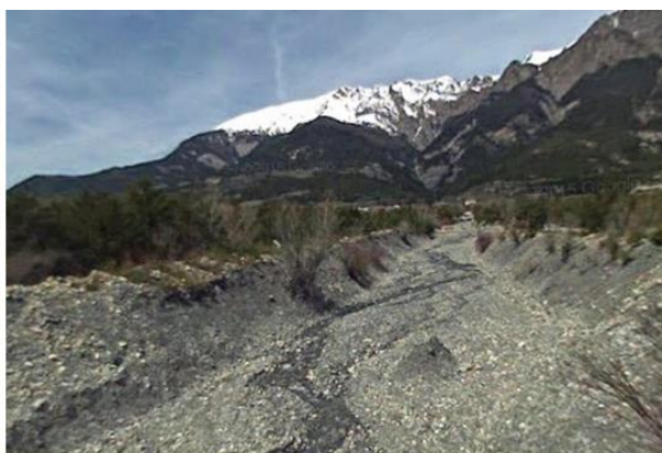
Digues vues depuis le pont de la D900 (vue vers l'amont)
