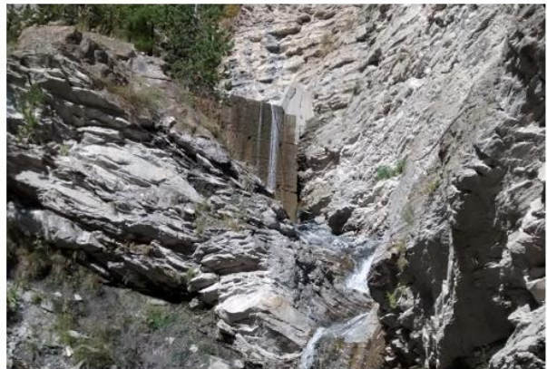
Un des ressauts rocheux de ce secteur : aval du B28 (1700 m)
