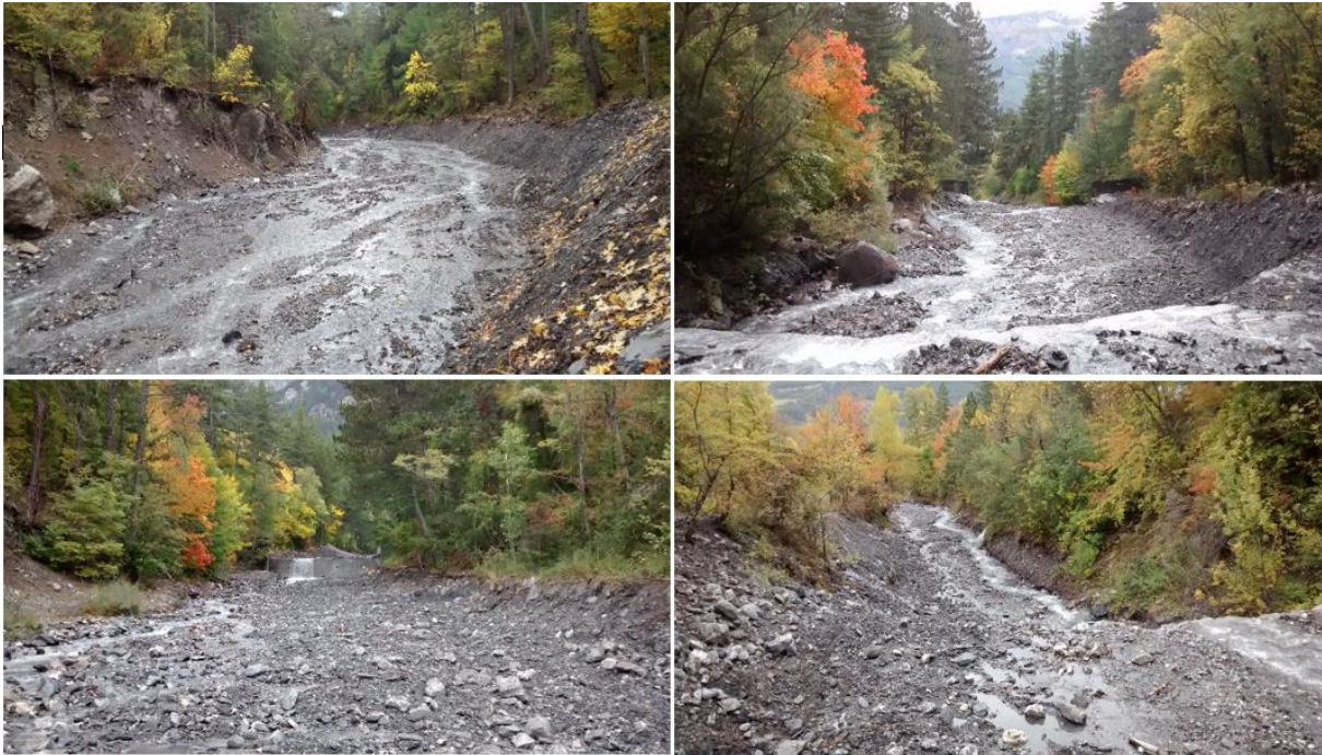
Figure 76. Photographies du remodelage du lit réalisé en 2015
