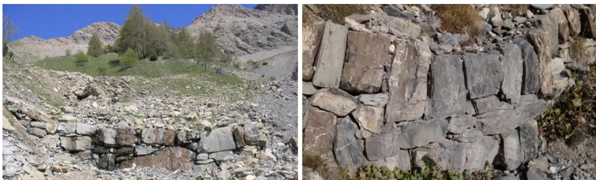
Figure 56. Clapière Faucon – Photographies de seuils en pierres sèches encore présents
