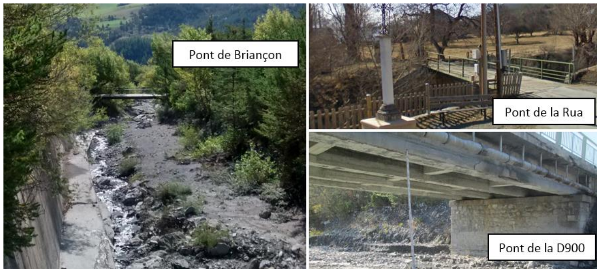
Figure 58. Photos des ouvrages de franchissement
