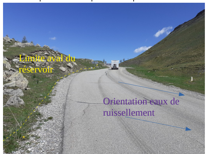
Vue de la chaussée en direction du col de Vars aux abords du captage
