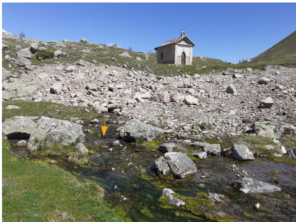
Vue de la zone de captage et du trop plein reconstitué alimentant la zone humide
