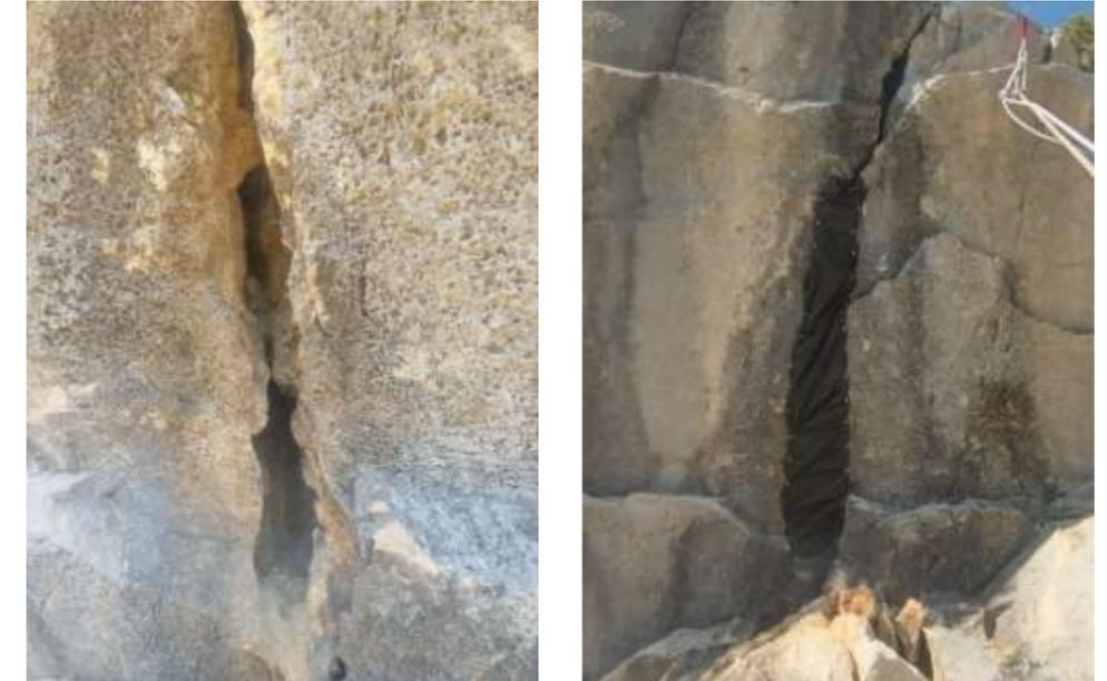
Exemple de comblement de fissure à l'aide de géotextile et de chevilles (cavité d'origine à gauche et bouchée à droite)
