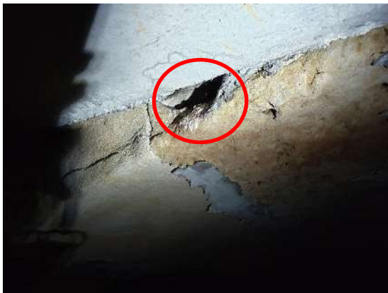
Figure 1 : Gîtes potentiels à chiroptères sur l'aire d'étude rapprochée, photos prises sur site, © Biotope.
