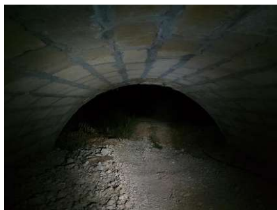
Ouvrage de franchissement des cours d'eau temporaire sous la RN85
