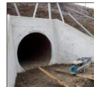
Figure 5-25: Exemple d'aménagement en entonnoir (Source : Internet)
