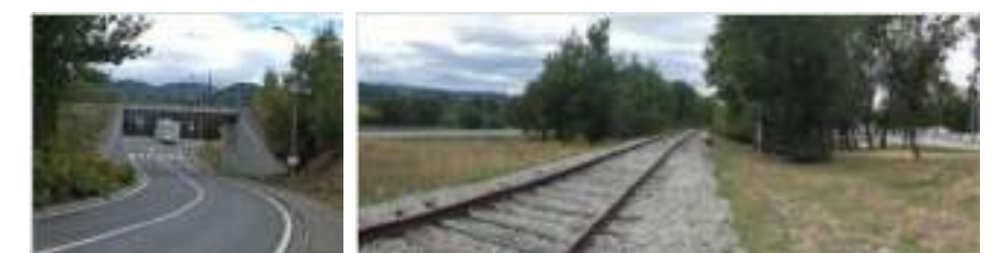
Figure 3-182: Vue sur le passage inférieur sous la voie ferrée permettant l'accès au village d'Aiglun – Vue depuis le talus de la voie ferrée
