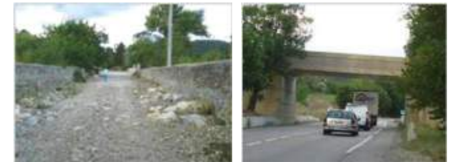
Figure 3-176: Pont sur la RN85 canalisant le ravin des Cathelières
