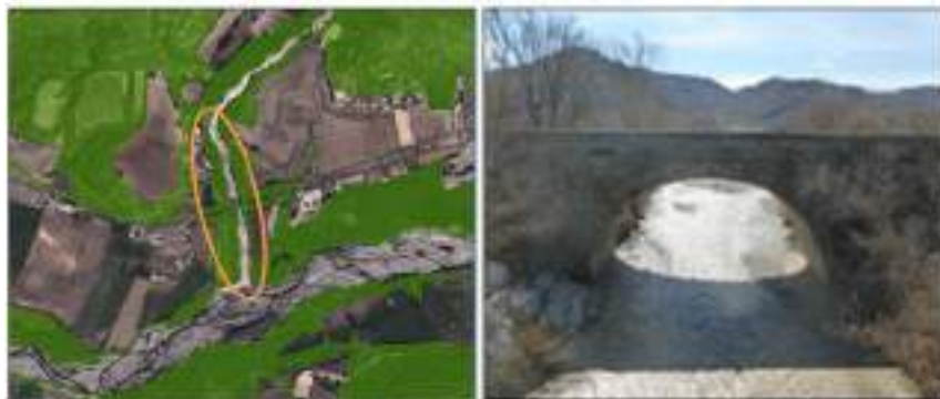
Figure 3-74: Vue aérienne du torrent des Duyes (à gauche) et Franchissement des Duyes par la RN85 (à droite). (Source : SEGED – L.DUCASSE, mars 2013, Mirabeau – Mallemoison)
