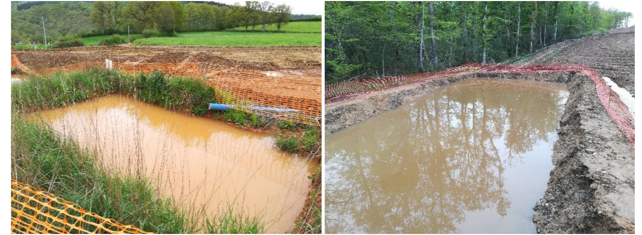
Exemples de bassin provisoire
