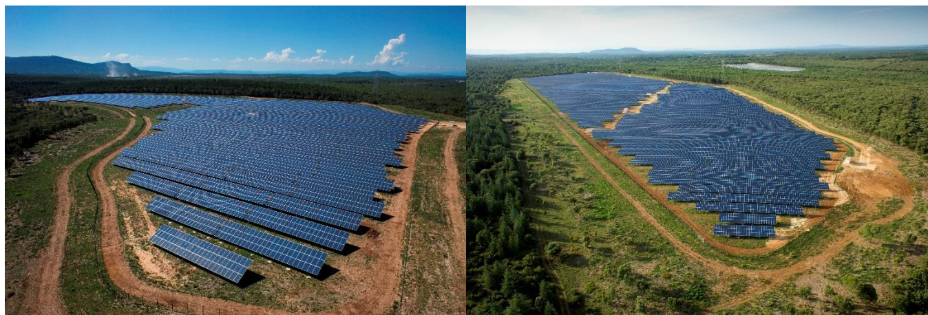
Photo 2 : Centrale solaire de Belvesol dans le Gard (20 MWc)
