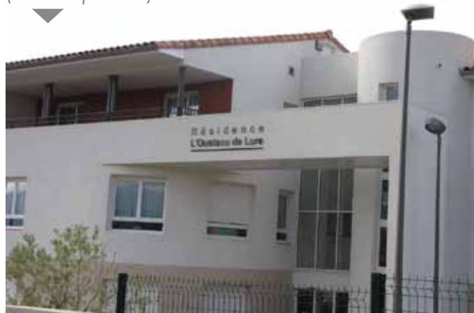
Maison de retraite «Oustaou de Lure» à Peipin (ouverture juin 2011)
