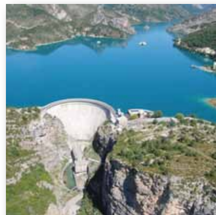
Barrage de Castillon
