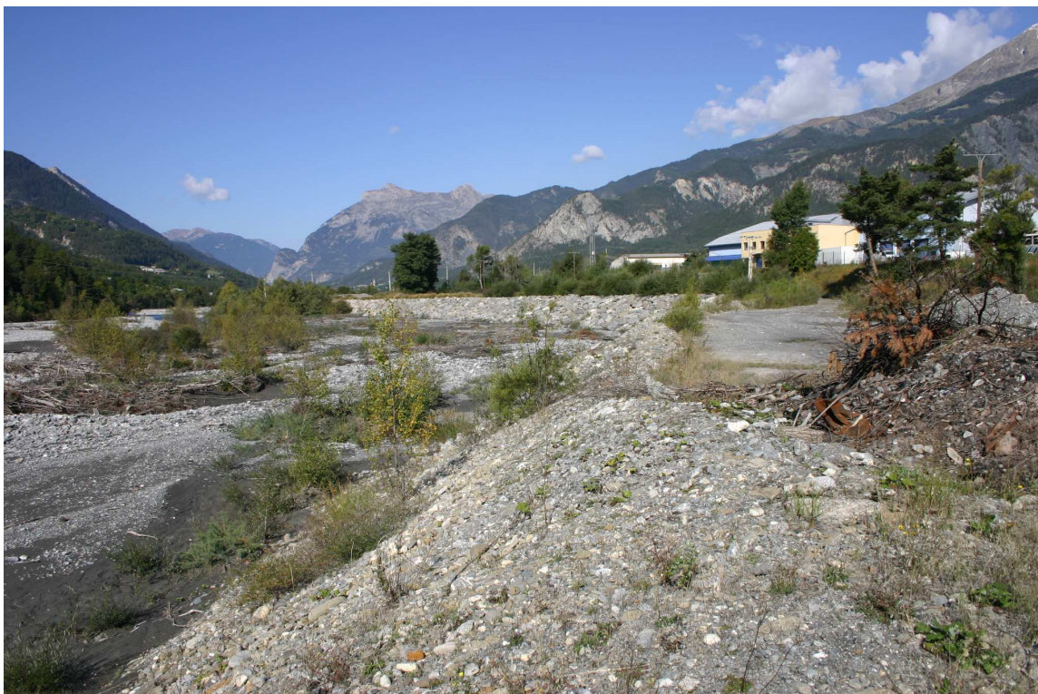
Photo 5 : Protection de berges à la zone industrielle de St-Pons.
