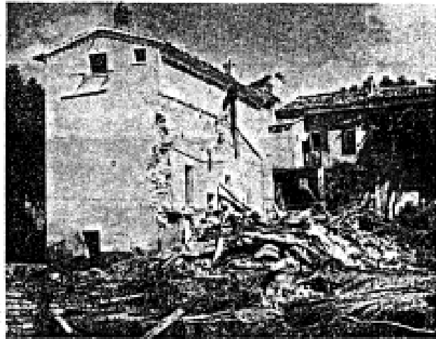
Le vague est passé par là : La maison de M. Cottarel a été soufflée par une explosion provoquée par un fat de carbone tassé. (Photo J. T. - Digne)
