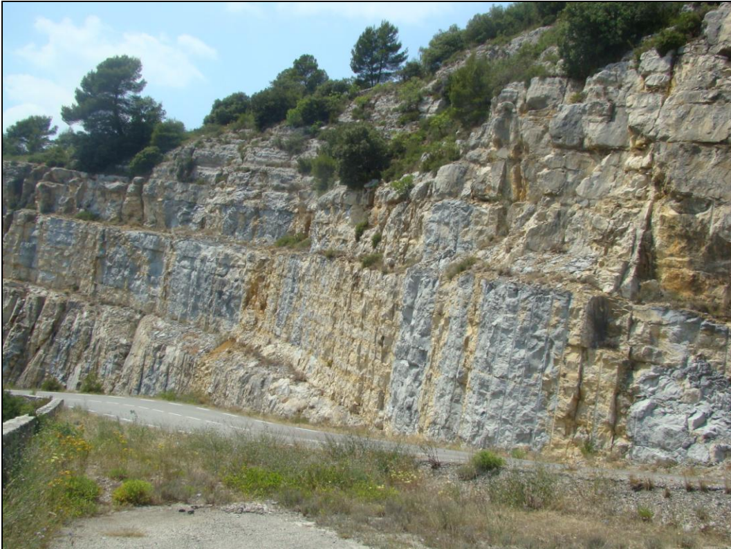
Figure 7 : Marno-calcaires Crétacé, RD 952 au niveau des gorges du Colostre [Source : IMS RN ]
