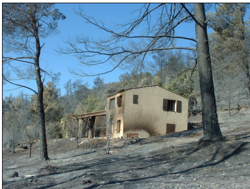
Corbières, habitation endommagée suite à l'incendie du 24/07/2002, photo : P. Richard, ONF.
