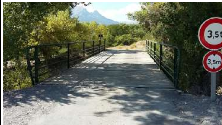
Photo 3 Extrados Vue générale depuis rive gauche
