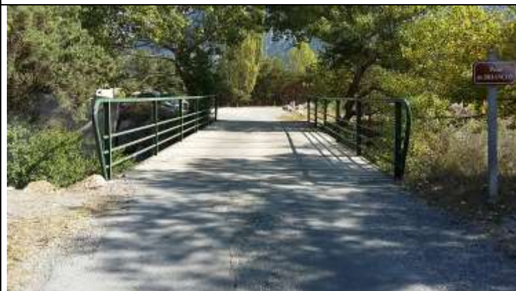
Photo 4 Extrados Vue générale depuis rive droite
