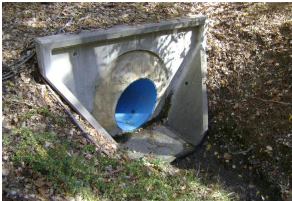
Illustration 16 : Extrémité de la buse Ø 800 mm dans le ravin de la Tour (source : Etude sol Concept, 2021)
