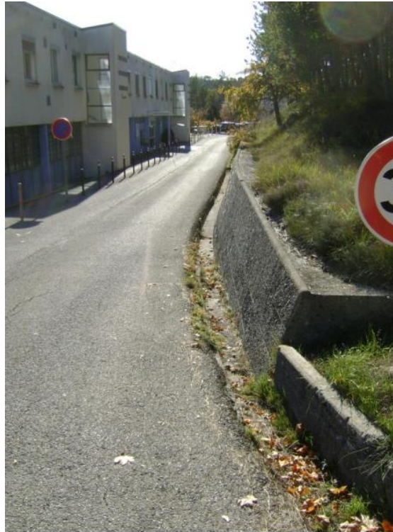
Illustration 15 : Vue de la voirie bordée par le caniveau (à droite) et le bâtiment « IFSI » à gauche (source : Etude sol Concept, 2021)
