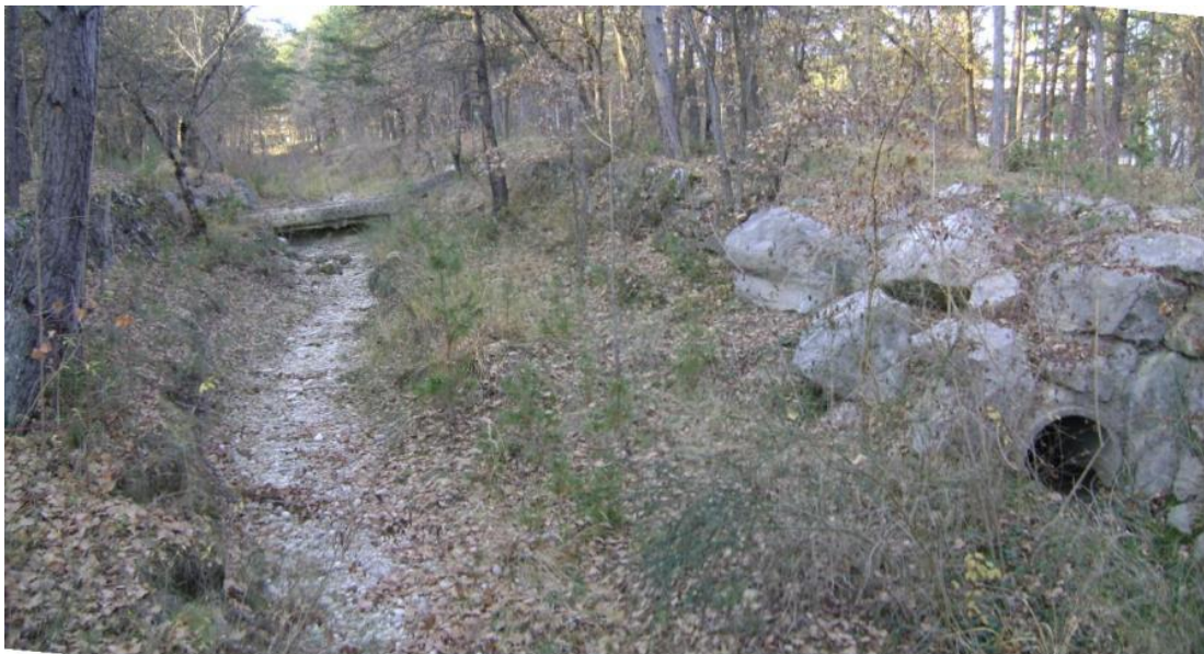
Illustration 17 : Photo du ravin de la Tour avec à droite la buse de \Phi 800 mm de sortie du réseau d'eaux pluviales (source : Etude sol Concept, 2021)
