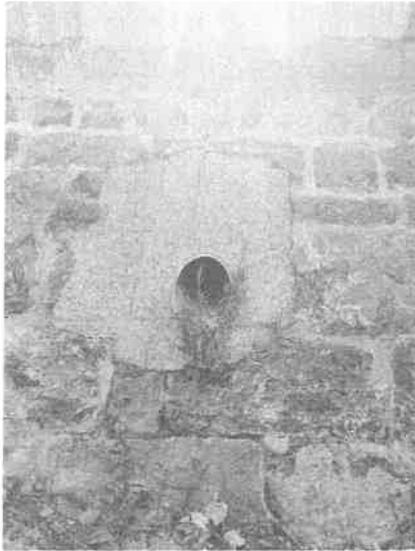
Exemple d'ouvrage de type pluvial déjà existant sur la digue des Epinettes amont avec raccordement au perré existant.
