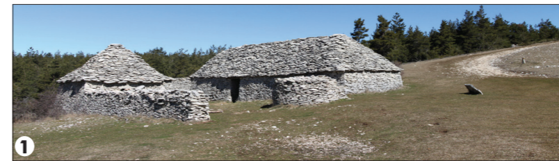
1 Jas des terres du Roux, bergerie, enclos et réservoir d'eau Crédit photos : L'Artifex
