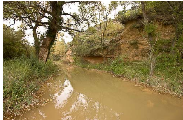
Un exemple d'instabilités de berge dans le ravin de Corbières, en aléa fort (photo Géolithe 2008)
