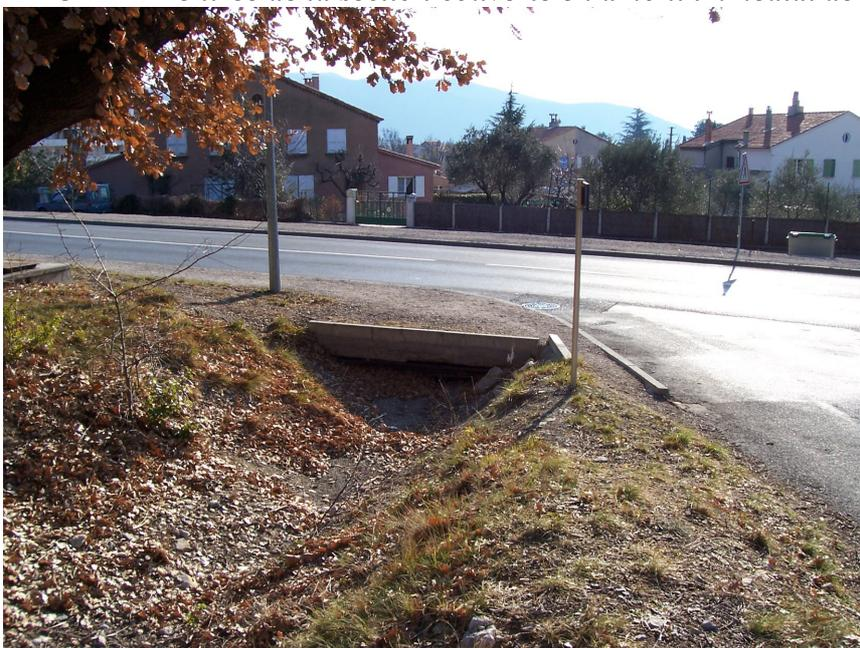
Dans la partie nord du versant de FANCHIRONETTE (au droit de la rue AMBROISE PARE), des débordements d'un petit ravin pourraient résulter d'une insuffisance de la section hydraulique (ou d'une obstruction) de la tête d'entrée dans le réseau souterrain (buse 800 mm de diamètre). Les divagations peuvent contribuer, avec les débordements du ravin de la rue de L'ADMINISTRATION, à inonder le secteur de l'hôtel VILLIARD.
