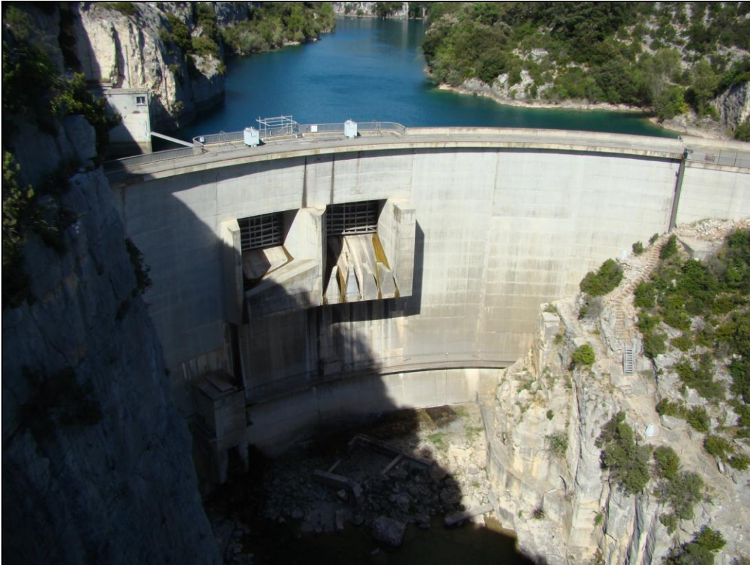
Figure 41 : Barrage de Quinson [Source : IMS RN ]
