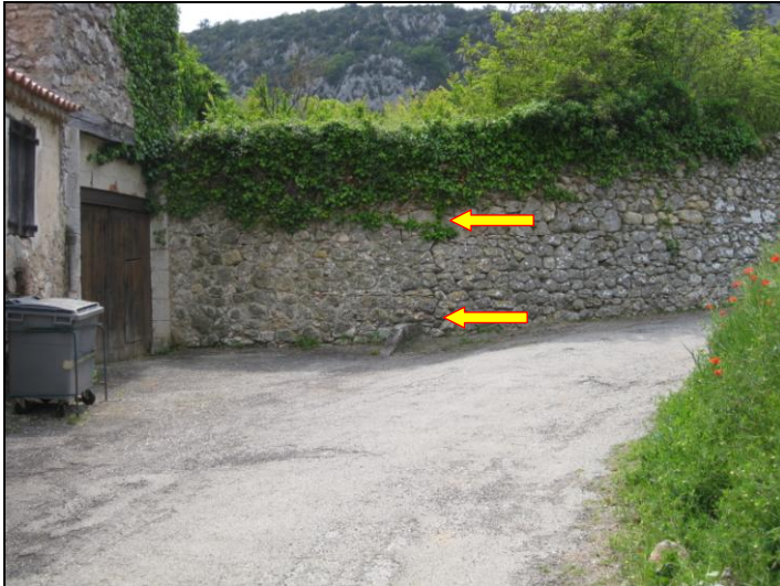
Figure 29 : Murs fissurés (à droite, celui du cimetière) dans le secteur de l'Apié et les Poiriers [Source : IMS RN ]
