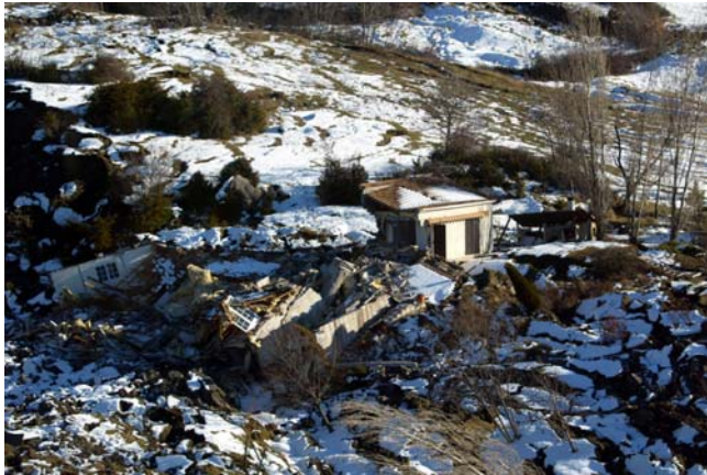
Le glissement du Villard des Dourbes, au-dessus de Digne, à l'hiver 2003 (photo Préfecture 04)
