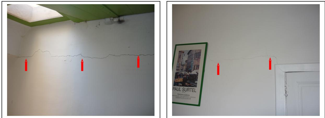
Figure 11 : Fissures dans constructions (centre du village) [Source : IMS<sub>RN</sub>]
