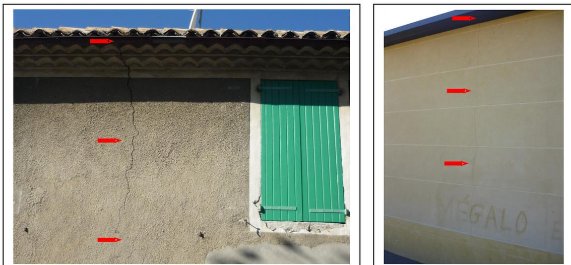
Figure 12 : Fissures dans constructions (centre du village) [Source : IMS<sub>RN</sub>]
