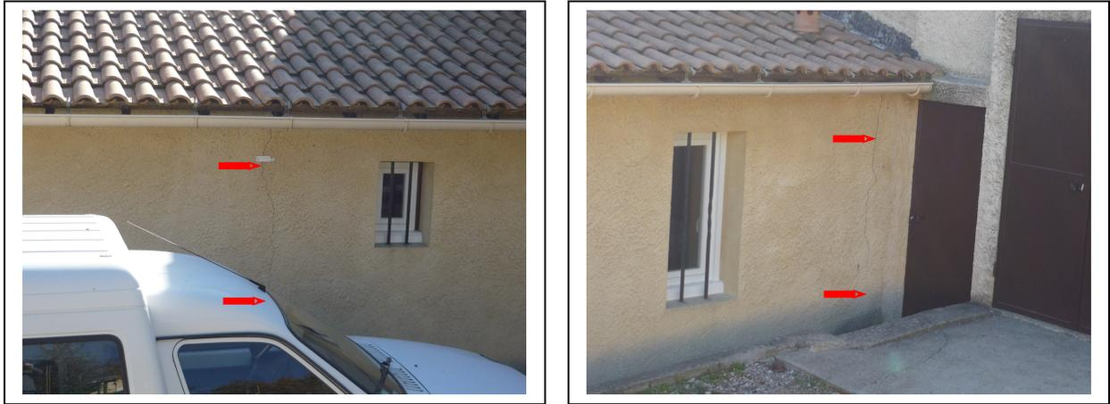
**Figure 13 :** Fissures sur une maison avec fissuromètre (lotissement Piolard) [Source : IMS<sub>RN</sub>]
