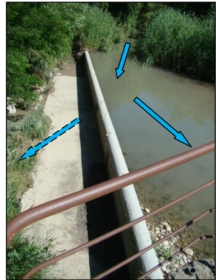
Figure 62 : Déversoir au niveau du canal EDF (à gauche) et seuil en bordure du torrent de Drouye en amont de la vanne martelière (à droite) [Source : IMS RN ]
