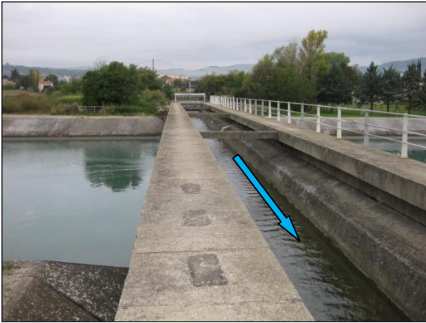
Figure 55 : Traversée du canal EDF par le torrent de Drouyes [Source : IMS RN ]
