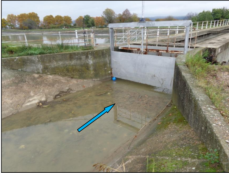
Figure 61 : Vanne martelière en position basse (à gauche) et système de verrouillage sur la crémaillère (à droite) [Source : Mairie de Manosque]
