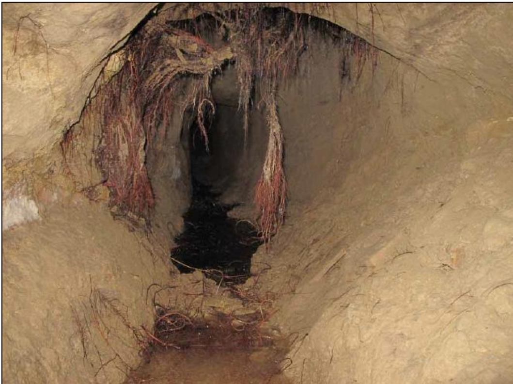
Figure 20 : Galerie [Source : BRGM]
