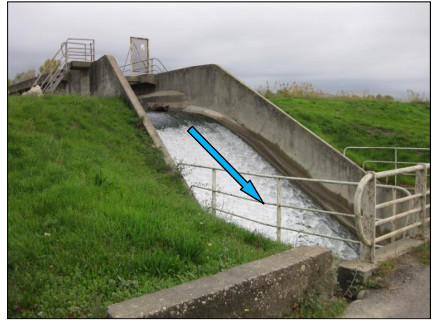
Figure 55 : Traversée du canal EDF par le torrent de Drouyes [Source : IMS RN ]
