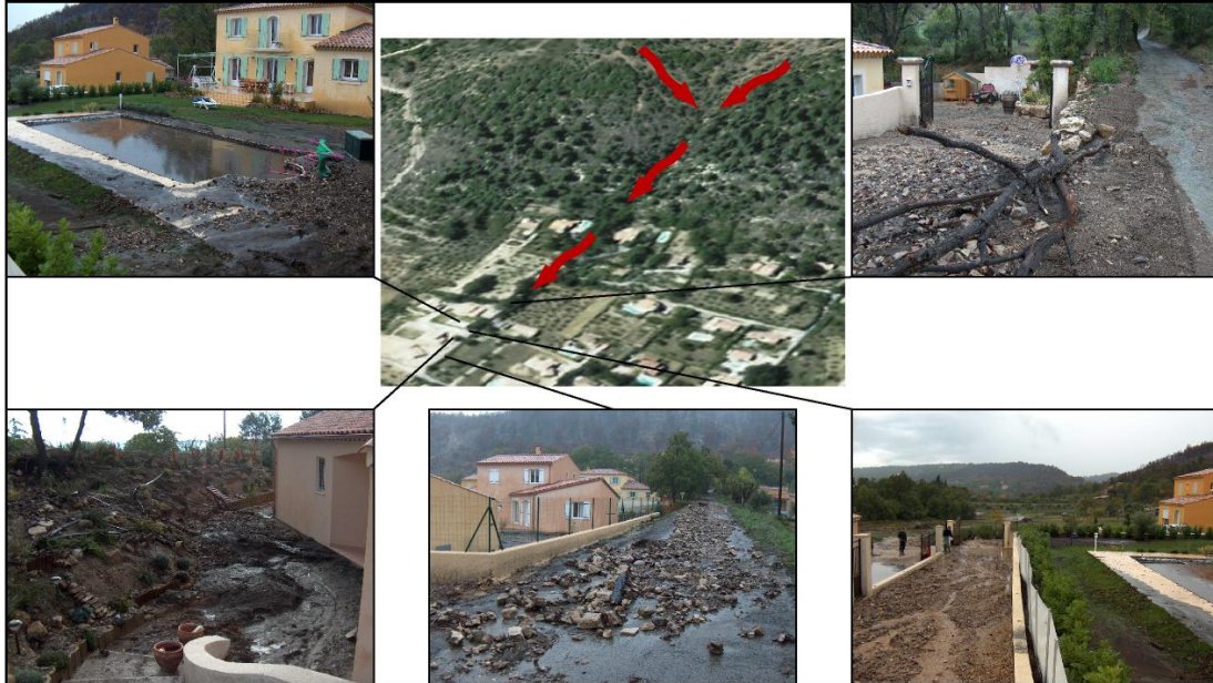
Figure 35 : Coulée de boue dans le secteur du Chemin de la Thomassine et de l'Impasse du Pimparin (Site STM07) [Sources : DDT 04 et IMS RN ]
