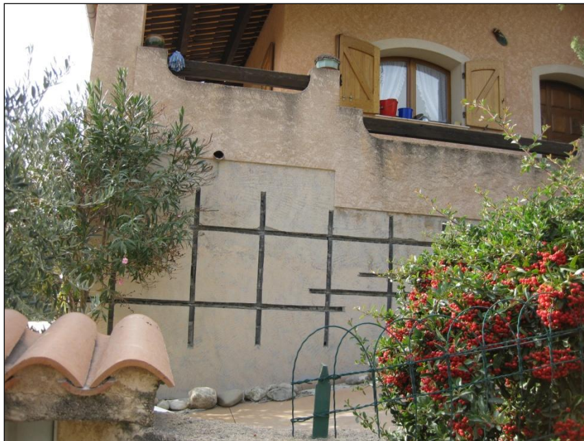
Figure 38 : Travaux de confortement sur une villa dans le secteur du Pain de Sucre [Source : IMS RN ]
