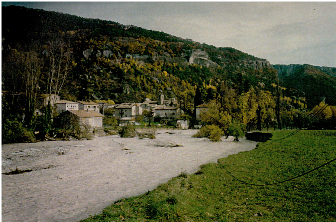
Crue de la Vaire du 5 Novembre 1994 - Affouillement à l'entrée du bourg
