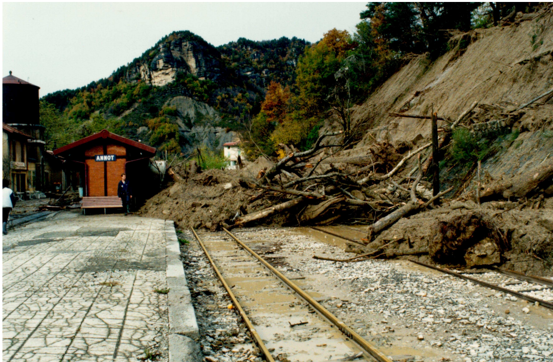
Une des 2 coulées de la gare du 5 Novembre 1994
