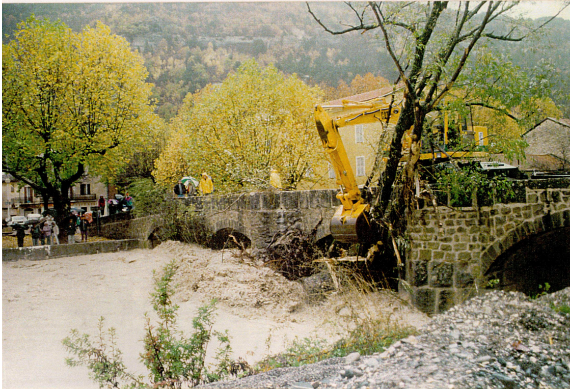
Crue de la Vaire du 5 Novembre 1994 - Le pont communal (vue depuis l'amont)
