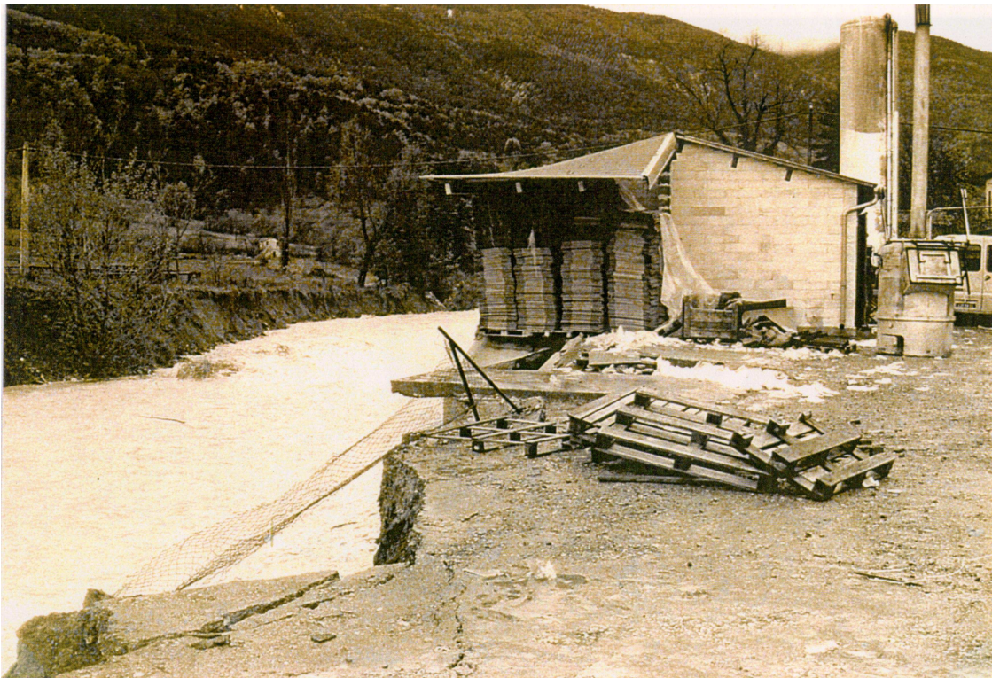
Crue de la Vaire du 5 Novembre 1994 - Affouillements sur les établissement Faissole
