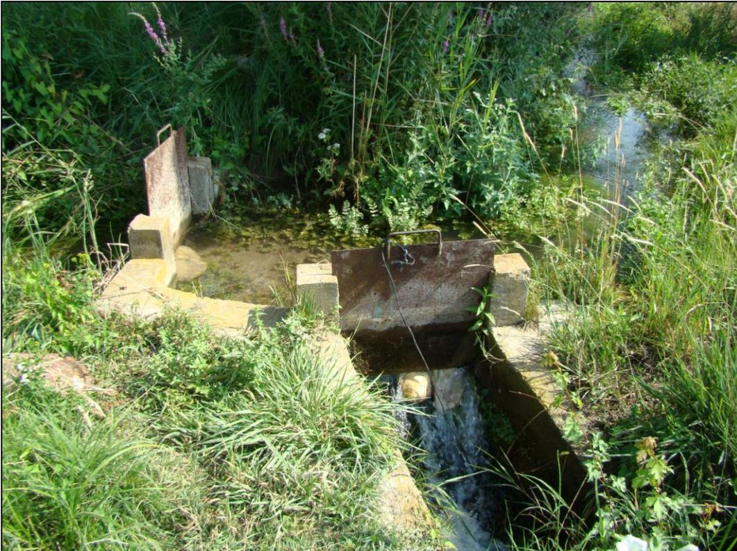
**Figure 30** : Vannes le long des canaux d'irrigation de la plaine du Colostre (secteur des Mouillères) [Source : IMS<sub>RN</sub>]
