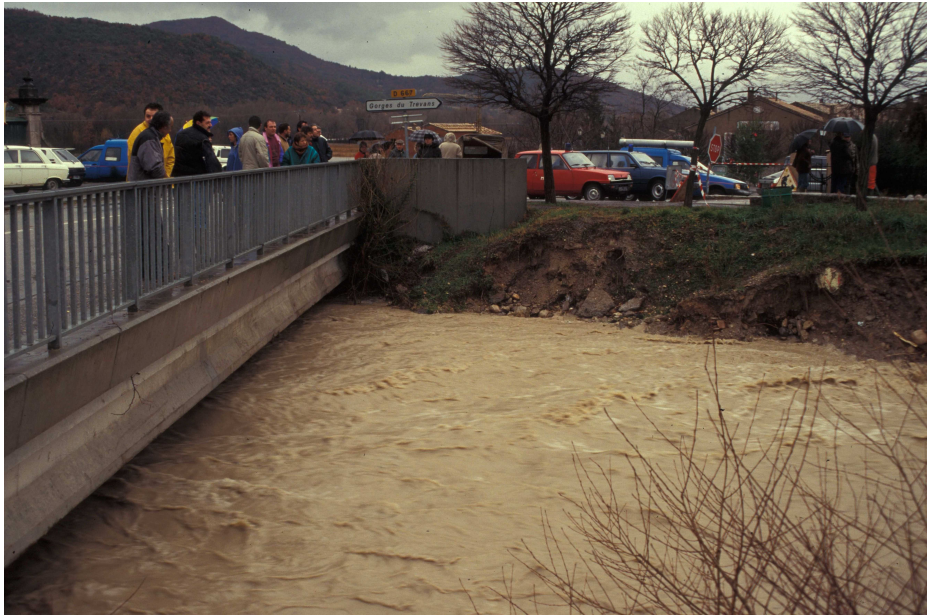
Photo1 : L'Estoublaisse - crue de janvier 1994 amont du pont de la RD 907 (cliché RTM04)
