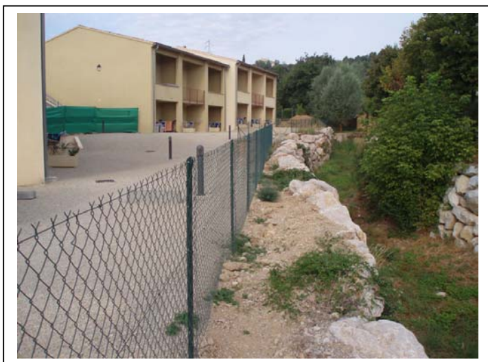
Photo n°5 : Partie aménagée du ravin de Goutette et résidence ODALYS inondable en rive droite – source MB management. août 2010.
