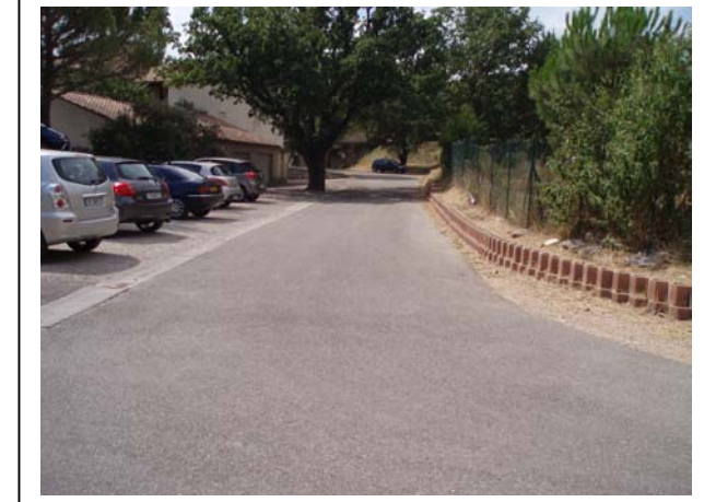
Photo n°7 : Lit du ravin occupé par un accès à des garages, résidence le Clos d'Eden, source MB Management, juillet 2010
