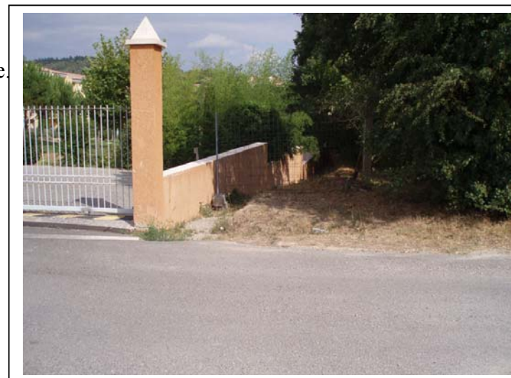
Photo n°4 : lit du ravin de Goutette, le long du mur de clôture de la résidence ODALYS – source MB management, août 2010
