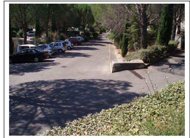
Photo n°9 et 10 : caniveau pour l'écoulement des eaux du ravin de Pujol, dans la traversée du parking, source MB Management, août 2010.
