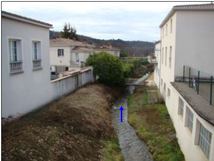
Figure 48 : Construction en bordure immédiate de l'Auvestre en aval de la RD 953 [Source : IMS RN ]
