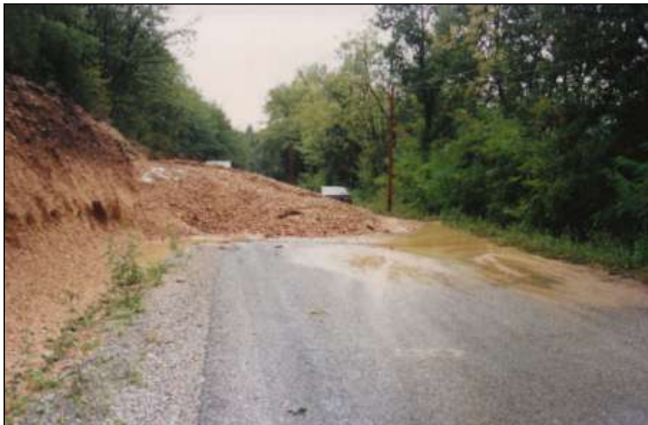
Figure 40 : Dépôt de matériaux sur la route entre ALLEMAGNE-EN-PROVENCE et RIEZ [Source : mairie d'ALLEMAGNE-EN-PROVENCE]
