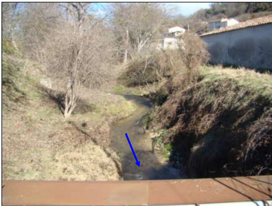
Figure 30 : Lit mineur de l'Auvestre au niveau de la passerelle en amont de l'hôpital [Source : IMS RN ]
