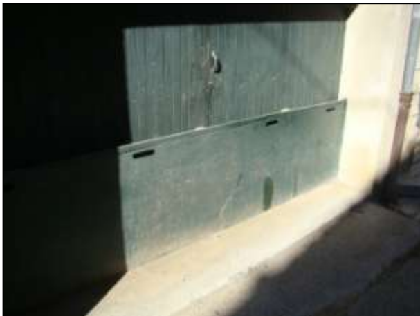
Figure 50 : Batardeau (à gauche) et réhaussement (à droite) en bordure de la RD 11 au niveau du pont Jacquet [Source : IMS RN ]
