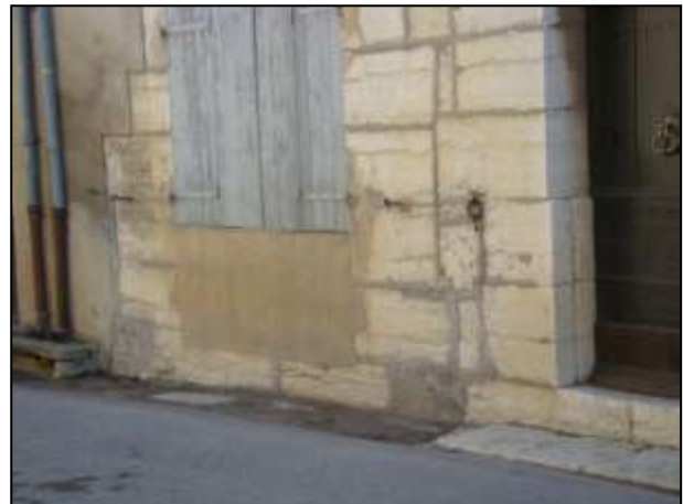
Figure 50 : Batardeau (à gauche) et réhaussement (à droite) en bordure de la RD 11 au niveau du pont Jacquet [Source : IMS RN ]
