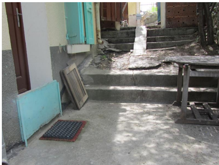
Illustration 23 : Batardeau permettant de se protéger des ruissellements de versant.
