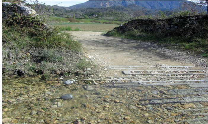
Illustration 11 = Passage aménagé traversant le lit du Champlong.
