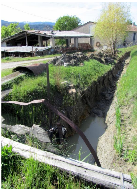
Illustration 24 : Canal d'irrigation_ lieu-dit Plaisance.
