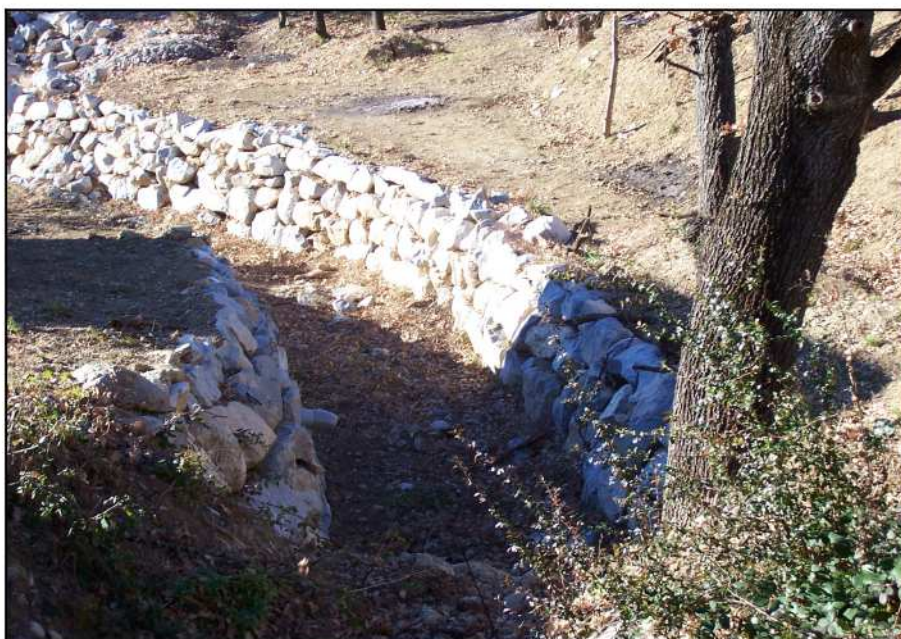
Photo 19: Ravin des baumes – Ouvrages de protection des berges en aval de la RD4.
