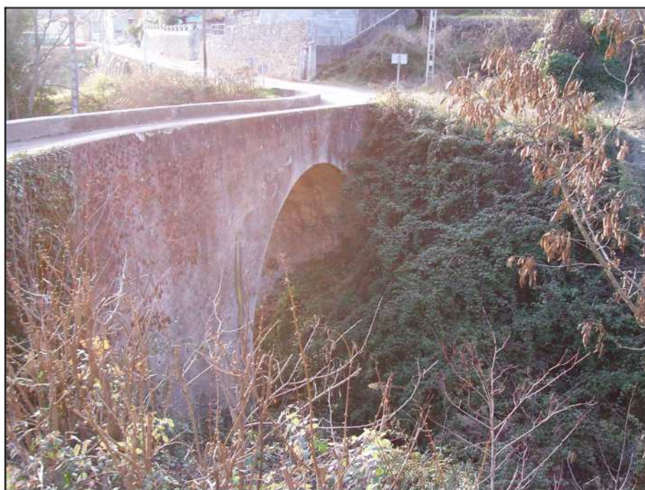
Photo 12: Pont de Viere surplombant le ravin de Grave.
