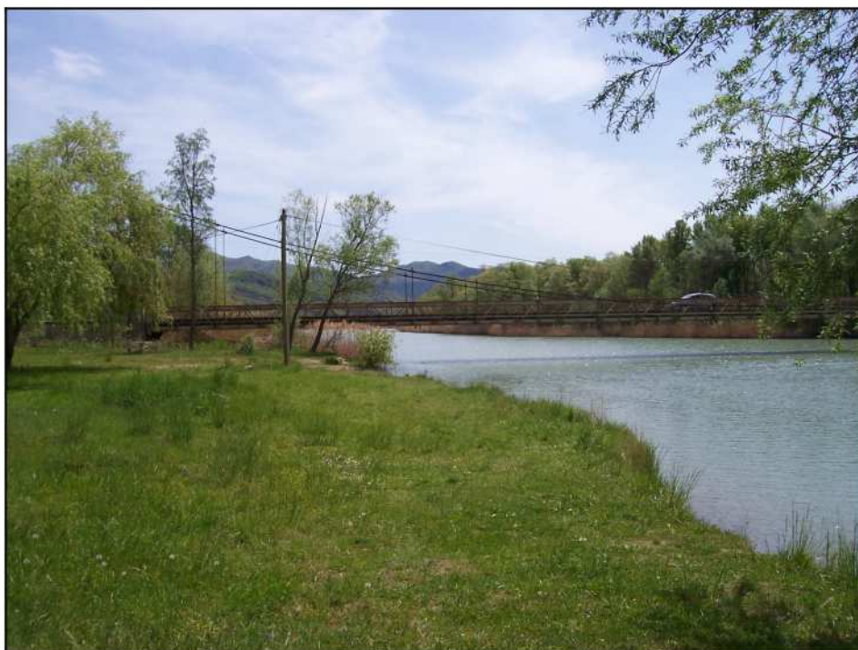
Photo 6: La Durance au droit de l'ancien pont de Volonne.
