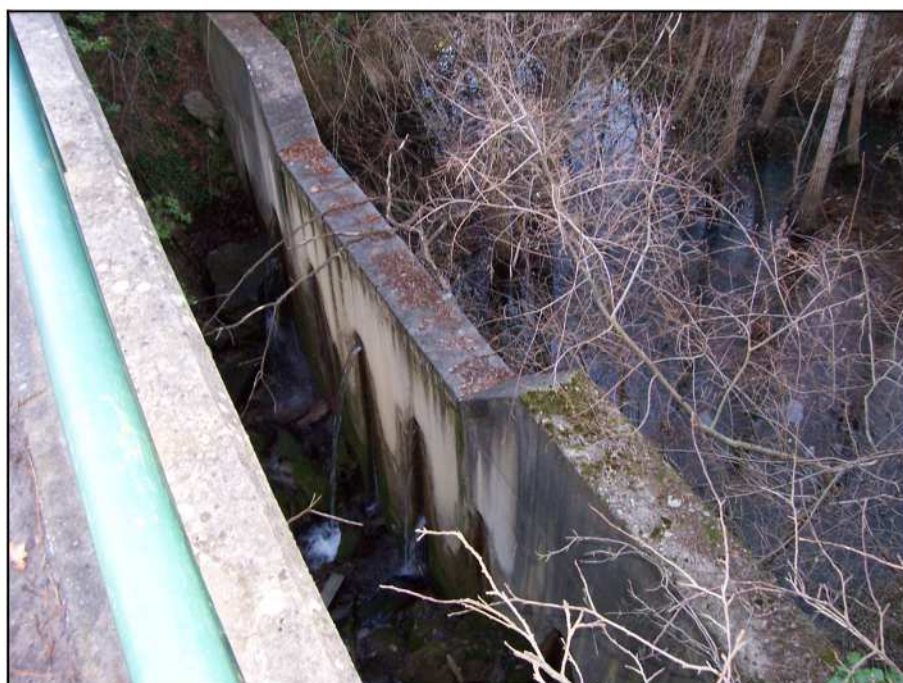
Photo 11: Ravin de Grave –barrage béton présent environ 300 m en aval de La Calade.
